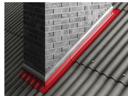
rys.51. Obróbka komina za pomocą taśmy kominowej.
